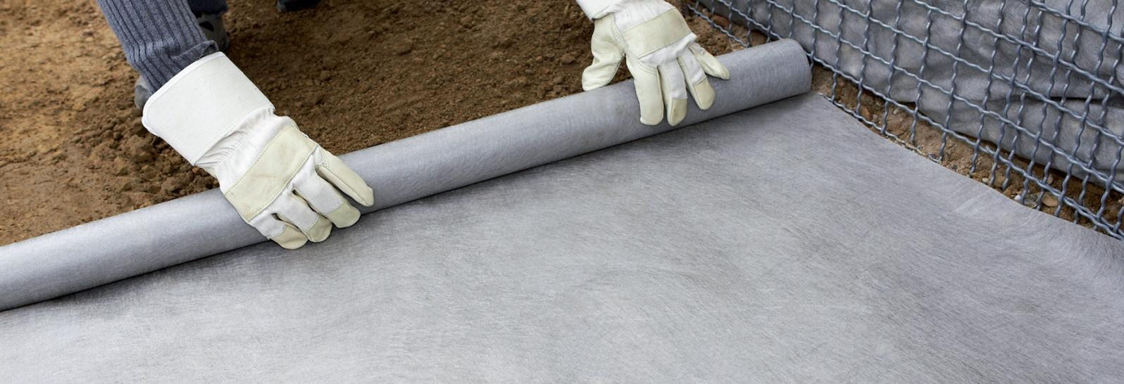
DuPont™ Plantex® Geoproma® es un geotextil 100% calandrado y resistente a la putrefacción. Evita la pérdida de soporte en el subsuelo y la migración de tierra hacia los sistemas de drenaje. Plantex® Geoproma® garantiza obra llanas, y eso de forma duradera. Además, sus propiedades filtrantes aseguran un drenaje continuo. Es químicamente inerte, no se deteriora, y es inocuo para el medio ambiente.
